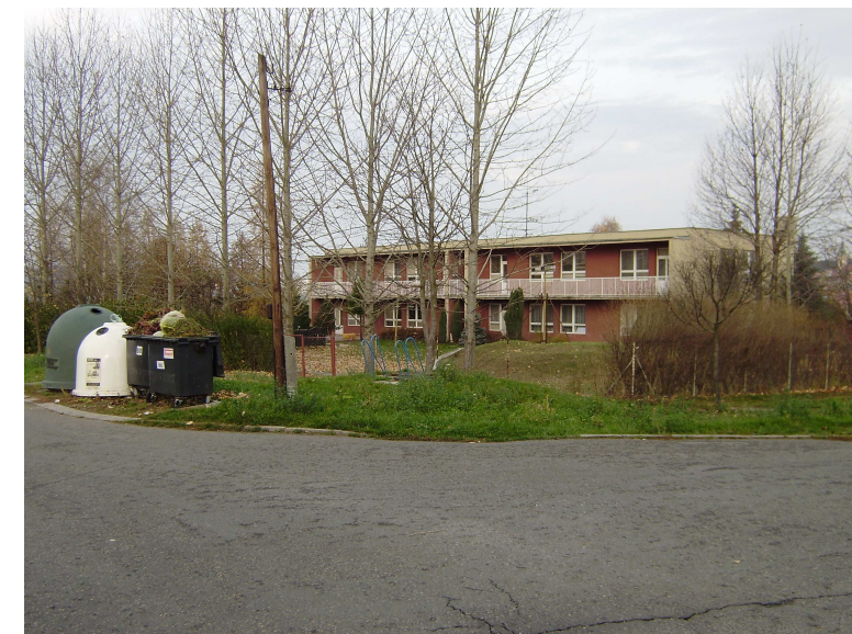
Mateřská škola Olšava – před realizací zateplení
