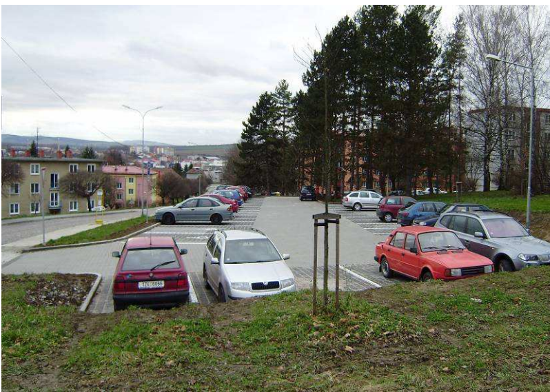
nově vybudované parkoviště ul. Hlavní
