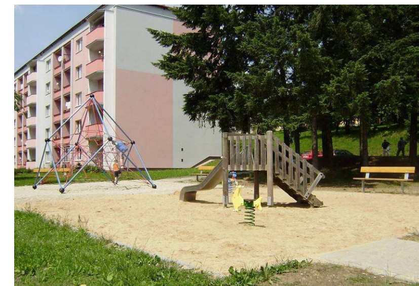
rekonstrukce dětských hřišť
