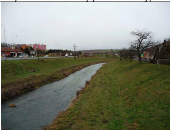
Úsek od křižovatky na Nivnici pohled k západu, rozpadlý vegetační doprovod.
