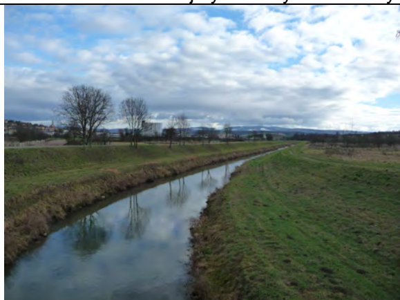
Úsek s alespoň částečným vegetačním doprovodem, pohled od západu směrem k městu
