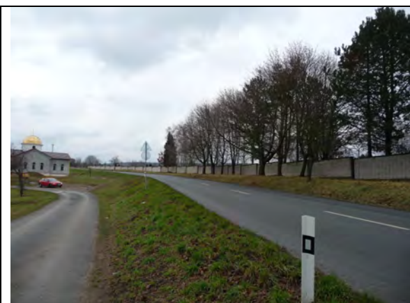
POhle od města k Prakšicím - mezernaté stromořadí podél hřbitova, pohled na vznikající pravoslavný kostel - nová dominanta, osy potvrzeno též novou linií podél cyklostezky (mimo záběr).
