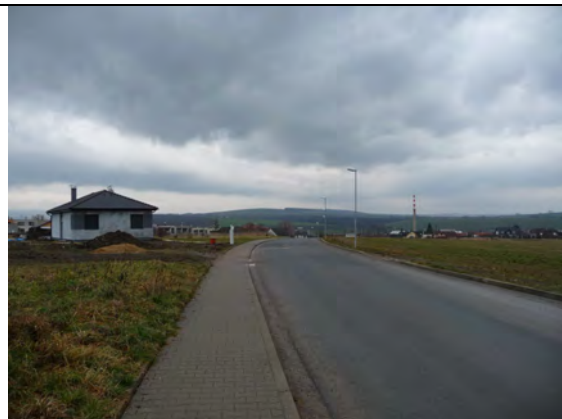
Neutěšený stav kolem nové výstavby, na stromořadí není pamatováno.
